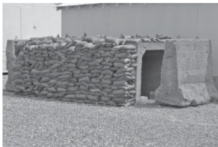
Obr. 3: Pohotovostní úkryt z výpomocného materiálu (železobetonové U-rámy a T-valy)
