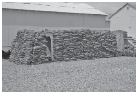
Obr. 3: Pohotovostní úkryt z výpomocného materiálu (železobetonové U-rámy a T-valy)
