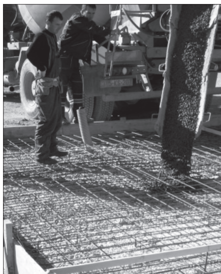
Obr. 3: Betonáž
