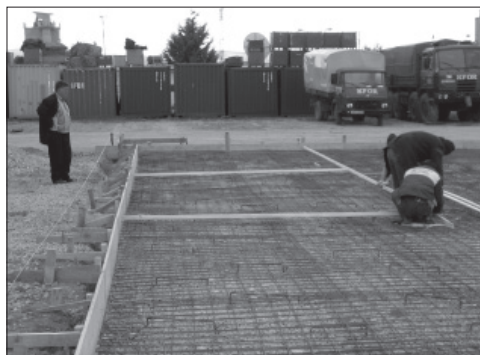
Obr. 2: Uložení karisítě a tvorba dilatačních spár
