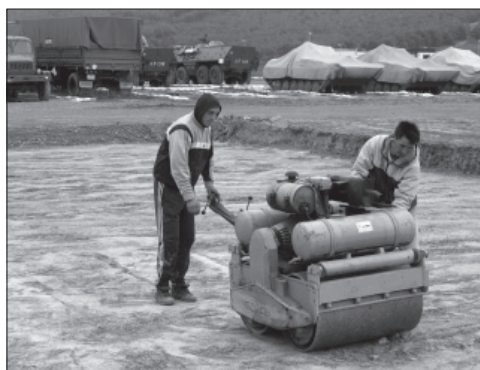
Obr. 1: Zhutnění podloží
