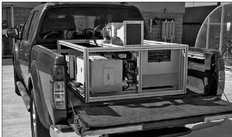
Obr. č. 14: Instalace systému RF Safe Stop 30
