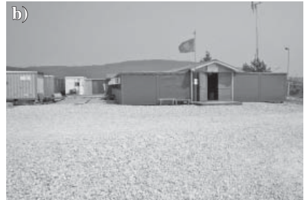
Obr. 5: a) Foto chodby ubytovacího bloku zastřešené pomocí polykarbonátových desek, b) Pohled na ubytovací blok sestavený z kontejnerů britské výroby
