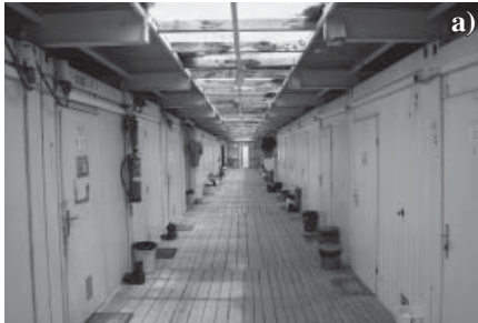
Obr. 5: a) Foto chodby ubytovacího bloku zastřešené pomocí polykarbonátových desek, b) Pohled na ubytovací blok sestavený z kontejnerů britské výroby
