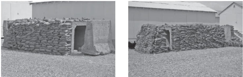
Obr. 3: Pohotovostní úkryt z výpomocného materiálu (železobetonové U-rámy a T-valy)
