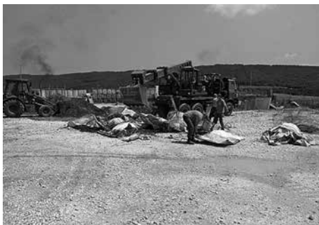
Obrázek č. 4: Rušení ochranných staveb ze systému HESCO a následné třídění materiálu.
