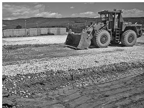
Obrázek č. 7: Odstraňování ekologické zátěže prostoru výdejny PHM (odběr vzorků/těžba kontaminované zeminy).
