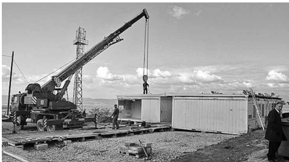
Obrázek č. 6: Ženijní a logistické jednotky demontují pracovní prostory štábu z kontejnerů ISO 1C
