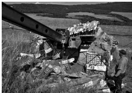
Obrázek č. 4: Rušení ochranných staveb ze systému HESCO a následné třídění materiálu.
