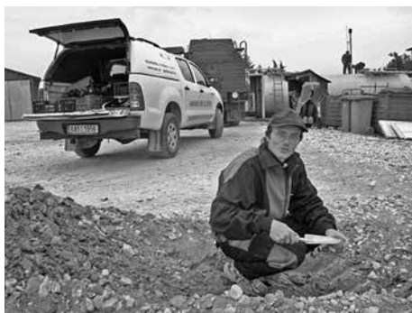
Obrázek č. 7: Odstraňování ekologické zátěže prostoru výdejny PHM (odběr vzorků/těžba kontaminované zeminy).
