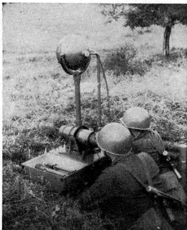
Obr. 7. Střední infradalekohled (zdroj — 2voltový akumulátor je umístěn v okopu za pozorovatelem — na obrázku ho není vidět)
