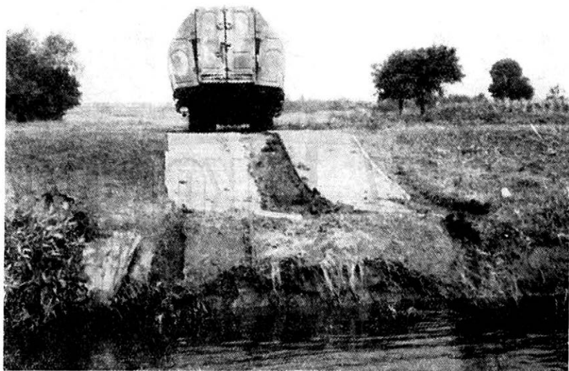
Obr. 1. Stupeň v úrovni vodní hladiny na regulovaném nedlážděném břehu; málo únosný břeh je zpevněn kolejovou vozovkou PMS
