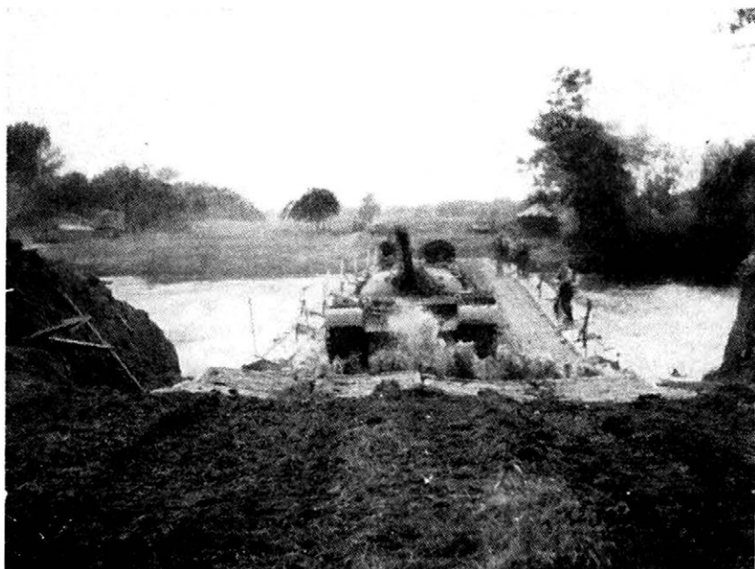
Obr. 3. Most PMS únosnosti 60 t s upravenými a zpevněnými přístupy; v rampové části mostu vlny vzduší, způsobené jízdou tanku T-54 po mostě
