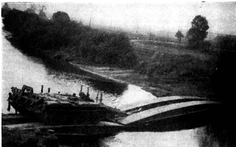
Obr. 3. Závěrečná fáze pokládání druhého mostu MT-55 A při přemostování vodní překážky dvěma položenými mosty za sebou
