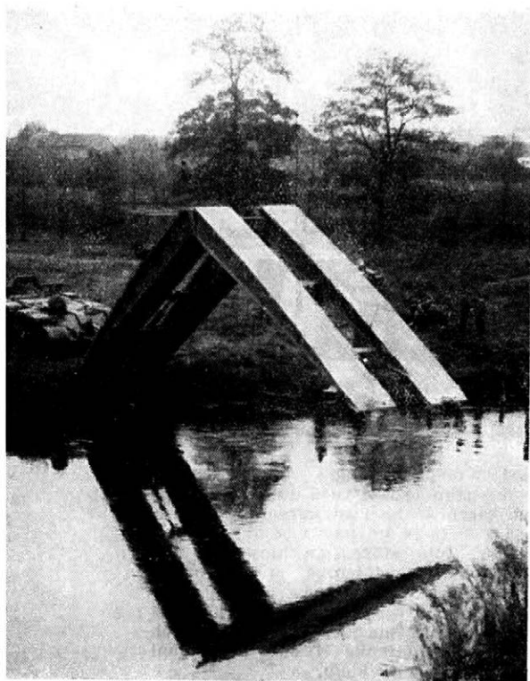
Obr. 1. Pokládání prvního mostu MT-55 A do překážky široké cca 30 m k přemostění dvěma mosty položenými za sebou
