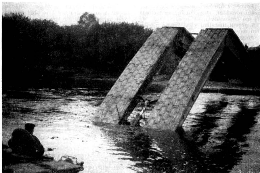
Obr. 2. Pokládání mostu MT-55 A v brodu
