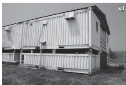
Obr. 6: a) Kontejner se sociálním zařízením a jímkou pro odvod splaškové vody, b) Zásobník na vodu
