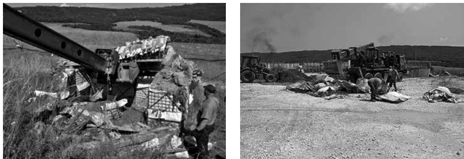
Obrázek č. 4: Rušení ochranných staveb ze systému HESCO a následné třídění materiálu.
